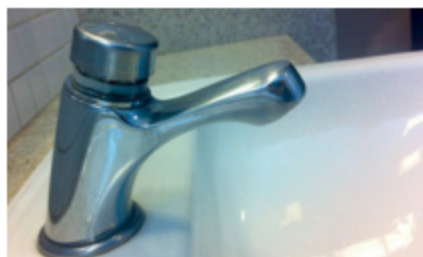
Figure 2: Bathroom faucet at BPE. © N. B. Cardoso.
