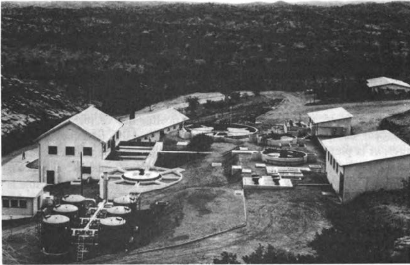
FIGURE 32 La ville de Windhoek au Sud-Ouest africain (84.000 habitants) au bord du désert de Namibie recycle ses eaux usées municipales grâce à cette usine de traitement pour ensuite les repomper dans le réseau d'adduction d'eau potable. (National Institute for Water Research, Pretoria, Afrique du Sud)
