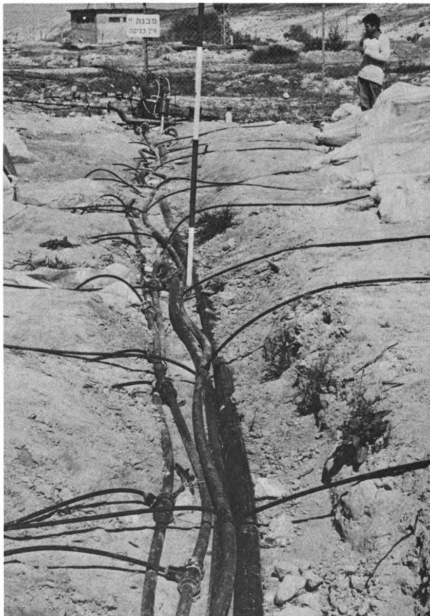
FIGURE 59 Tuyaux de plastique pour l'irrigation par filets d'eau utilisant l'eau d'une nappe aquifère géothermique saumâtre, Mashabei S'deh (Israël). A la différence d'autres méthodes d'irrigation, celle-ci peut facilement maintenir l'eau chaude avec les tuyaux isolés. L'eau chaude réchauffe le sol, stimulant la croissance des plantes en éliminant la froideur de la nuit dans le désert. (J. Schechter)
