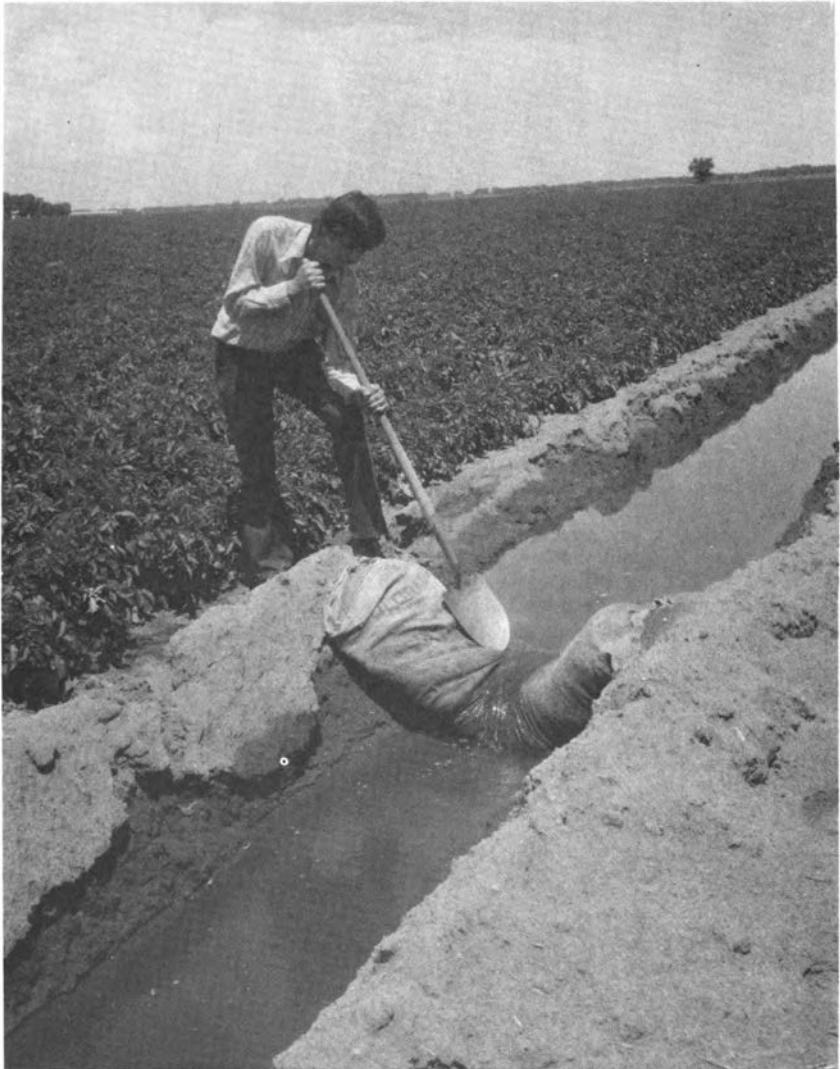
FIGURE 67 Sous-irrigation dans la Vallée du San Luis au Colorado (Etats-Unis). Comme dans la Figure 66, cette méthode irrigue la zone des racines sans humidifier la surface du sol, mais elle fait remonter artificiellement la nappe aquifère dans la zone des racines. Dans la pratique, la nappe phréatique alimente des fossés latéraux. De petites barrières sont utilisées pour élever le niveau de l'eau dans le fossé; l'action capillaire fait remonter la nappe phréatique dans tout le champ. Comme l'approvisionnement en eau vient d'en dessous de la zone des racines, une très petite quantité d'eau seulement atteint la surface du sol; cela réduit l'évaporation, la salinisation et la germination des mauvaises herbes. (USDA Soil Conservation Service)
