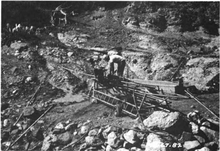
FIGURE 38 Forage d'un puits horizontal. Un tubage classique est enfoncé selon un plan légèrement incliné. Le matériel, léger et portatif, peut être transporté facilement, même sur des terrains accidentés. (W. T. Welchert)
