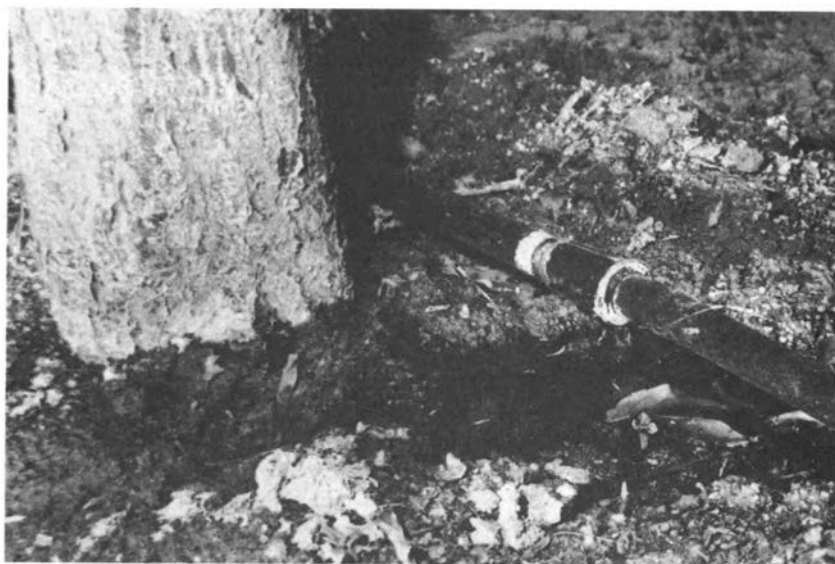
FIGURE 58 Diffuseurs d'eau pour l'irrigation. (F. K. Aljibury)
