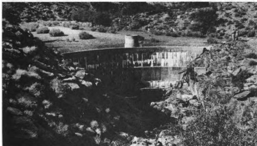
FIGURE 44 Barrage de retenue d'eau rempli de sable en Afrique du Sud-Ouest Ce barrage a été construit en béton. La construction par palières est nettement visible. Le puisard derrière la paroi du barrage est utilisé pour extraire l'eau. Les dimensions du barrage peuvent être estimées par comparaison à la taille des personnes à droite. (O. Wipplinger)
