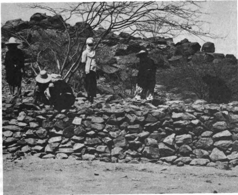
FIGURE 19 En 1972, près de la petite ville de Tchirozérine (à proximité d'Agadès) au Niger des nomades Touareg construisirent un mur de roches pour capter les eaux de crue. Les sols absorbent une couche d'humidité et les précipitations se transforment en crues "éclair". Au moyen de pierres recueillies dans les champs, les ouvriers Touareg ont construit huit murs de 1 mètre de haut à travers les plaines pour que le sol puisse retenir et absorber l'eau. Lorsque les averses de l'été sont tombées en 1973, l'eau retenue par les barrages et murs de pierres a inondé près d'un mille carré sur la plaine et de l'herbe a poussé-événement extraordinaire dans cette région. (Oxfam-America)
