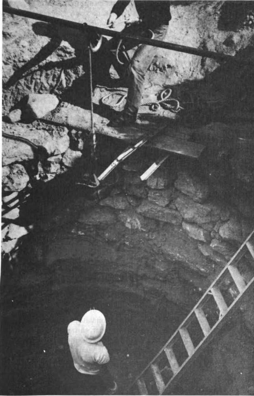
FIGURE 33 Creusement d'un puits ordinaire dans le désert du Néguev. (U. Nessler)
