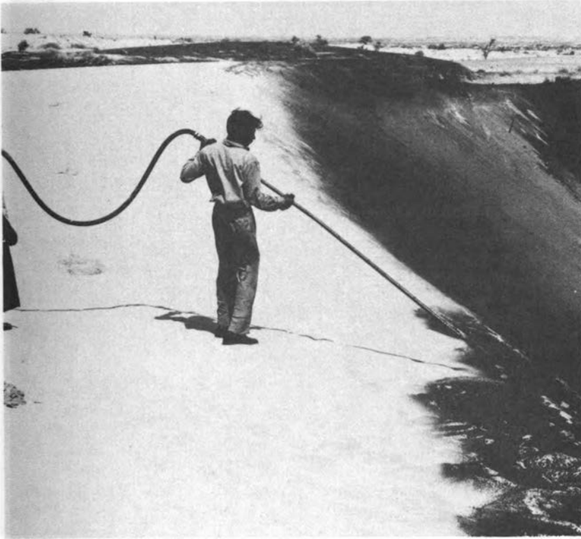
FIGURE 53 Stabilisation des dunes avec une épaisse couverture d'huile dans le désert de Rajasthan, en Inde. Ce processus a été appliqué pour la première fois en Lybie à 160 ha de bandes désertiques dans le désert du Sahara (voir aussi Figure 55). Les dunes contenaient de l'humidité jusqu'à 50 cm de profondeur. Après traitement on y a planté 60.000 eucalyptus dont 90 pour cent ont survécu à la plantation et ont continué de croître. Hauts d'un mètre lorsqu'ils ont été plantés, ces eucalyptus ont grandi de plus de 2 mètres pendant la première année. Du sable non stabilisé s'envolerait ou enterrerait les jeunes plants en découvrant leurs racines. (Exxon)
