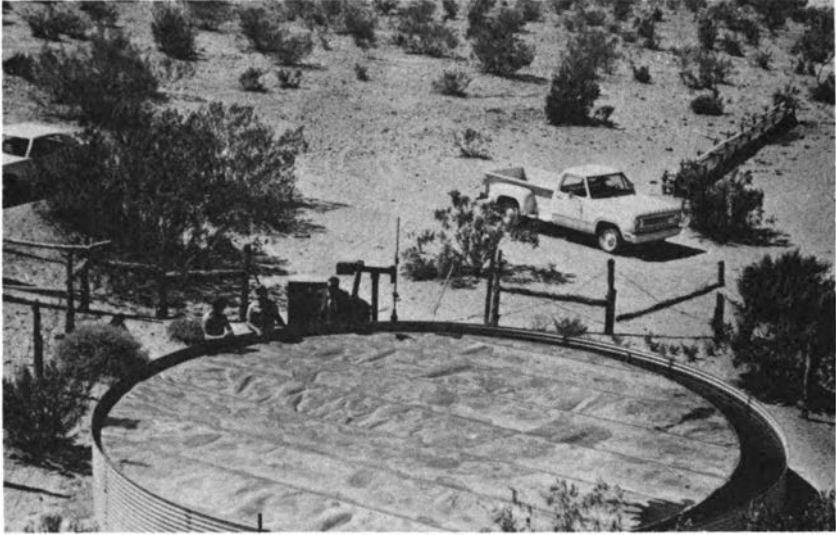
FIGURE 43 Les feuilles de caoutchouc-mousse flottantes (9 m de diamètre et 5 mm d'épaisseur) couvrent un réservoir d'eau près de St-George, dans l'Utah (Etats-Unis). L'expérience semble indiquer à ce jour que la couverture aurait une durée de vie de 10 ans et empêche l'évaporation à 80-90 pour cent. Le coût estimé de l'eau dans une zone d'évaporation de 120 cm par an est de 1,80 à 2 dollars E.U. (U.S. Department of Agriculture)
