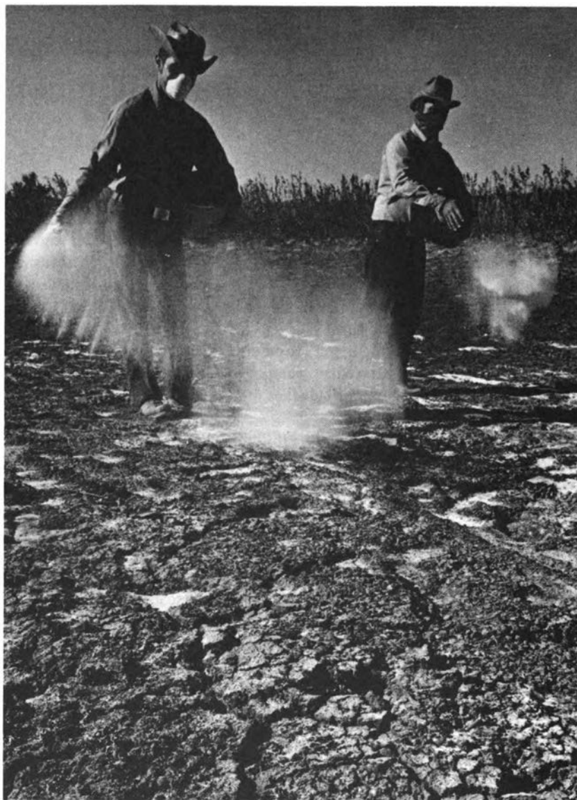
FIGURE 46 Les fissures dans le sol révèlent la forte teneur en calcium du lit d'un étang à sec dans la forêt nationale Coconino (Arizona) aux Etats-Unis. L'eau s'infiltré par les fissures; initialement les pertes d'infiltration dans cet étang de retenue de 1000 m 2 étaient de 5 à 12 cm par jour. Roches et mauvaises herbes ont été enlevées et une tonne (80 dollars E.U. environ) de carbonate de sodium a été répandue à la main. Ce carbonate a été ensuite mélangé au sol sur une profondeur de 8 cm environ au moyen d'un petit tracteur et d'un disque, et . . .
