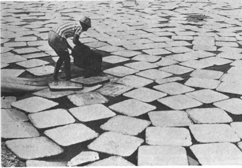
FIGURE 42 Une couverture protectrice de dalles de béton léger a réduit l'évaporation d'environ 80 pour cent à l'occasion d'essais réalisés récemment sur une vaste échelle dans deux réservoirs à Ovamboland (Afrique du Sud-Ouest). Des ingénieurs couvrent les réservoirs de dalles flottantes de polystyrène, de sable et de béton d'une épaisseur de 5 cm/60 cm. 2 La surface exposée de chaque dalle est peinte en blanc pour refléter le rayonnement solaire qui accélère l'évaporation.
