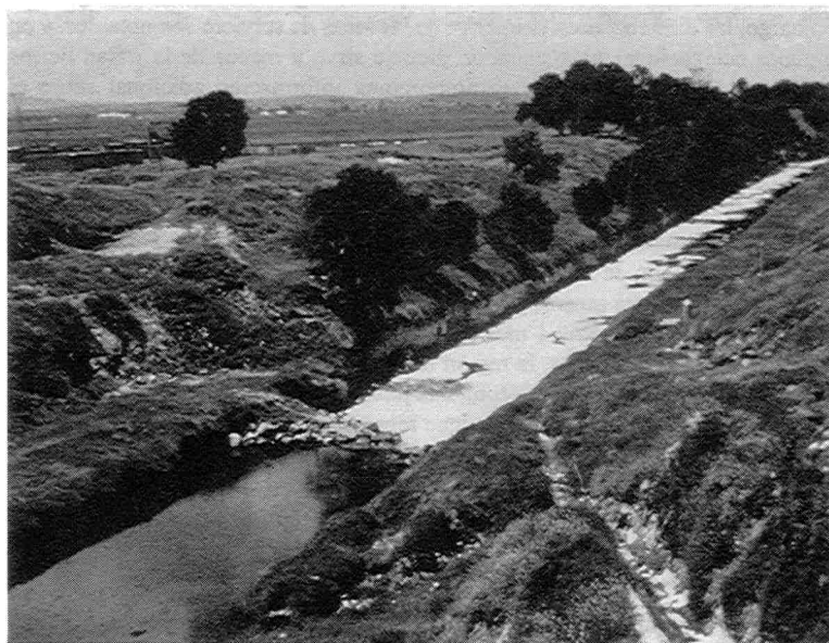
Fotografía 4-1 Vista del gran Canal del Desagüe, que transporte el agua pluvial y el drenaje proveniente del área metropolitana de la Ciudad de México. El Canal sale de la Cuenca de México a través del túnel de Tequisquiác y descarga en el Río Moctezuma a su vaz tributario del Río Pánuco que desemboca en el Golfo de México. Cortesía de Robert Farvolden.
