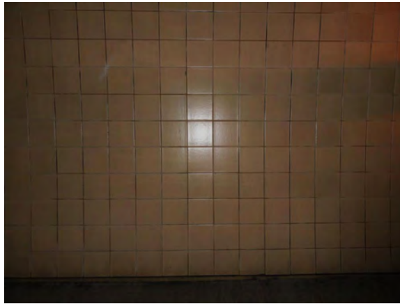
Figure N.17. Image of test site HLT 10.5-13.
