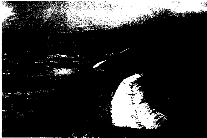
Figure 4.2 Concrete-paved Ditch (Coduto, 1999)
