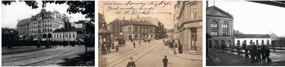
III.3.1-3: Kinematografer på Kristianas østkant. Glassmagasinet hvor Londoner Biografen holdt til i 2. etasje (t.v.), gateutsnitt av Brugata anno 1902. Tre kinematografer holdt til i denne gatestubben i 1910 (midten), Frysjahallen på Grønland som huset Grønlands kinematograf fra ca. 1906 (t.h.). Foto: O.Hvalbye/Norsk Folkemuseum, Ukjent/Oslo byarkiv, AB Wilsø/Oslo museum.
