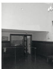
III 9.21-23: Billettluken sett fra vestibylen, med nedsenket tak som gir plass til maskinrommet.
