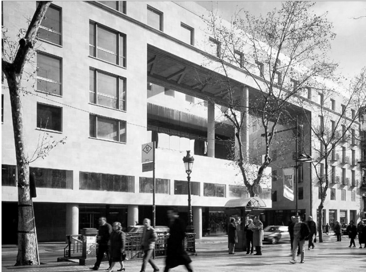
Fig 3.7 MBM, Palau Nou de La Rambla, Barcelona, 1994
