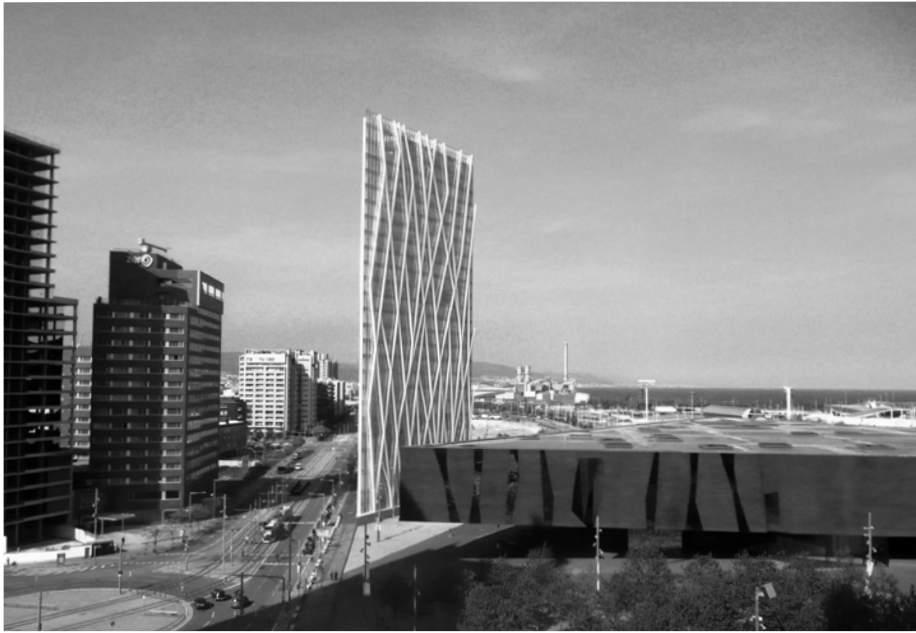
Fig. 3.45 EMBA, Torre Telefonica, Barcelona, 2010
