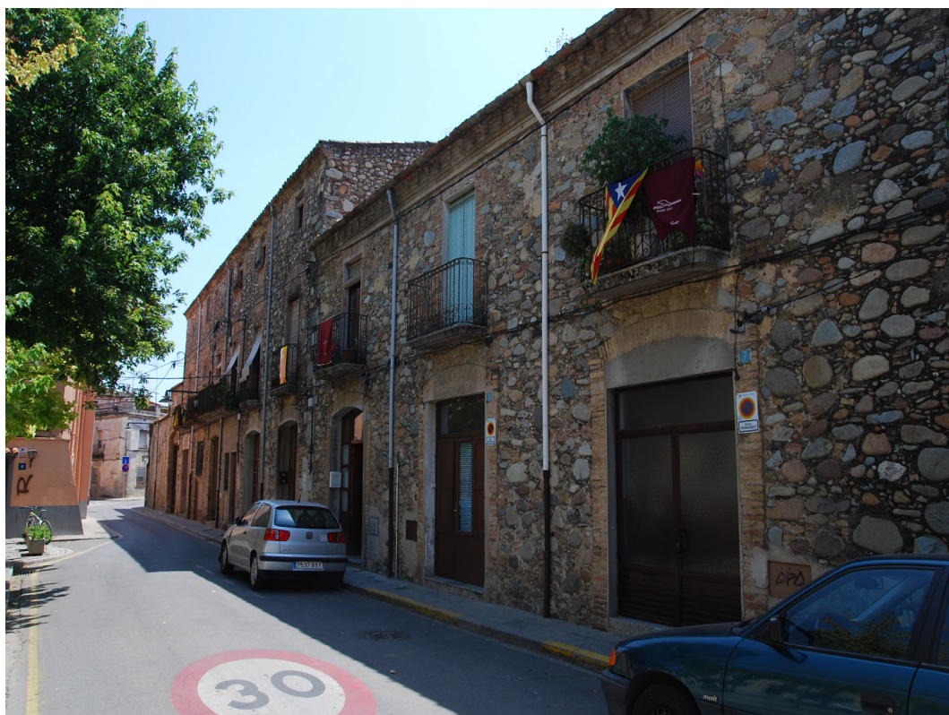
Casas bajas de la Plaça de la Vila, Barri Vell
