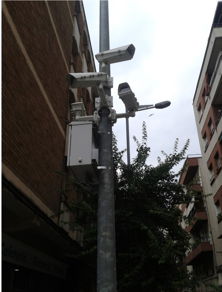
Cámaras de video-vigilancia instaladas en la calle Torres i Bages
